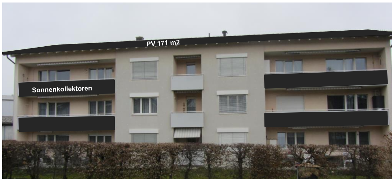
Abbildung 5.1: Photo, Skizze Dachaufsicht mit PV-Modulen/Kollektoren
